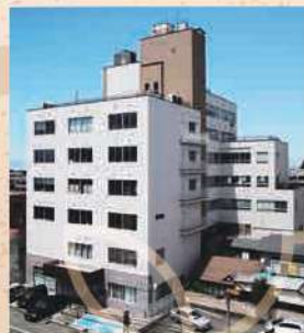
旧本町矢吹クリニック
